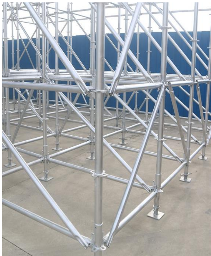
Рисунок 8. Визуализация инвентарных металлических оцинкованных строительных лесов.
